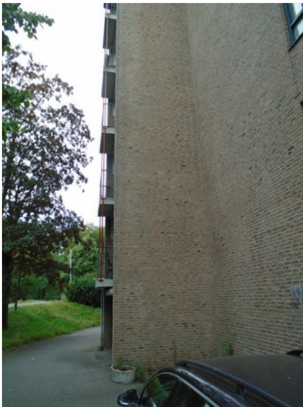
spouwmuur met open stootvoegen zuidzijde
