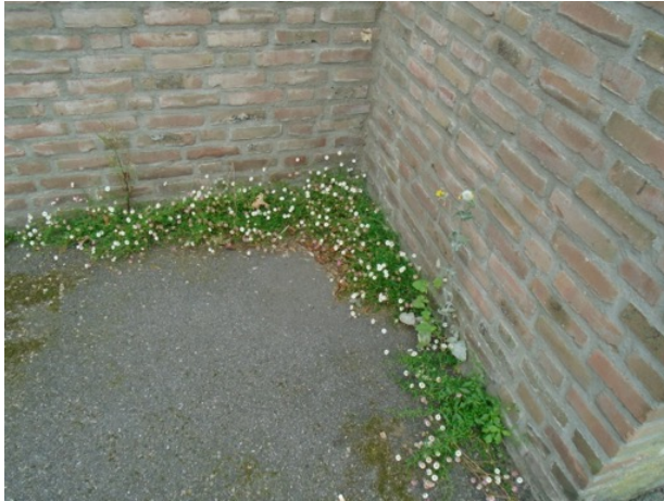
Muursla en Muurfijnstraal tegen noordzijde gebouw
